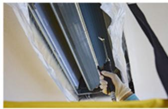
熱交換器を専用の薬剤でクリーニング。最後に抗菌・防カビ処理を施します。
